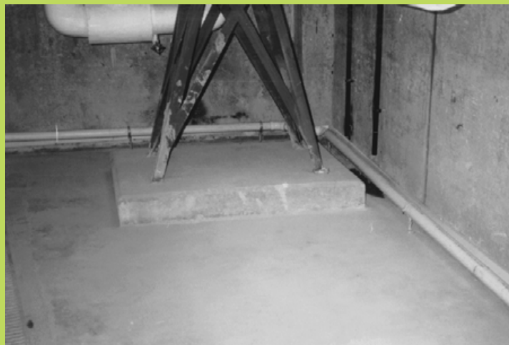
Suterén po inštalácii pulznej elektroosmózy
