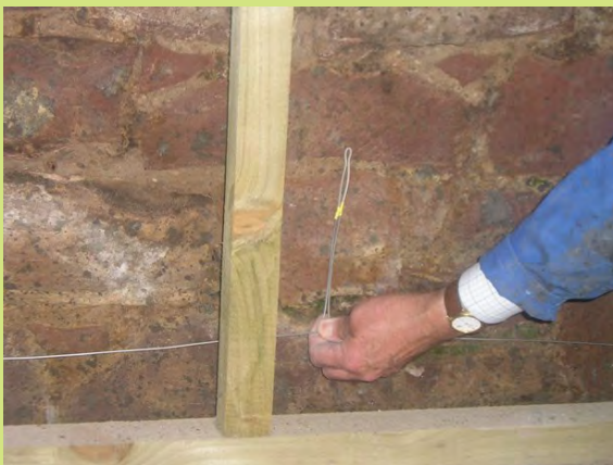
1. Anóda pripravená na vloženie do steny
