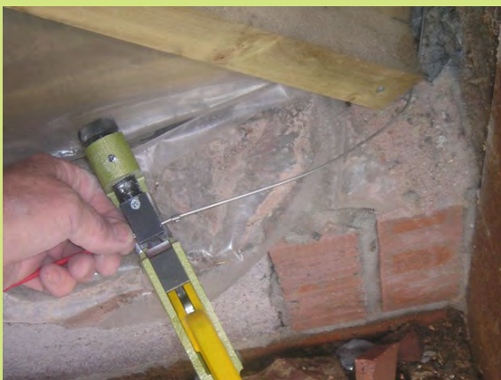
5. Prepojenie kábeláže krimovacími kliešťami
