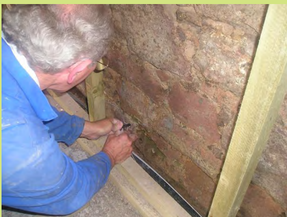
3. Vloženie anódy do otvoru a zaistenie poistkou
