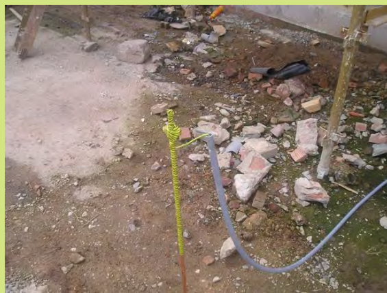
6. Zapojenie uzemňovacej tyče
