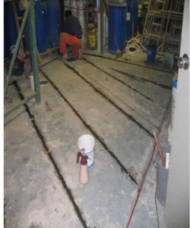
Vyrežanie drážok, uloženie kladných elektród a ich vyplnenie vodivou maltou
