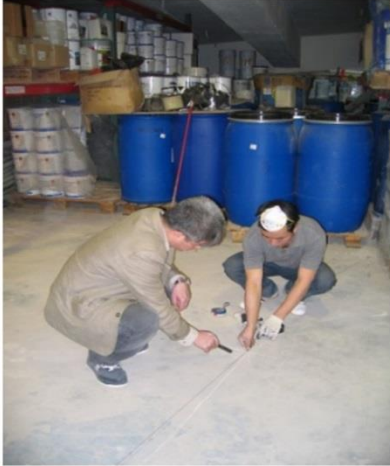
Vyznačenie pozície kladných elektród na betónovej doske
